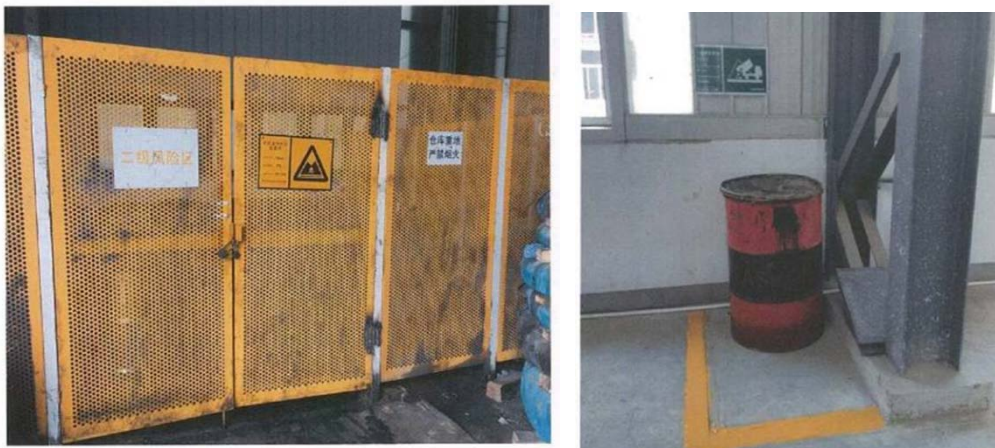
图 8 危险废物暂存间和一般工业固体废物暂存处规范化
